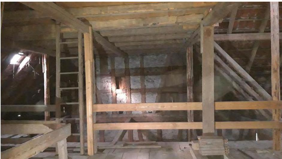
**Abb. 20:** Zwischenboden und spaltenreiches Mauerwerk
