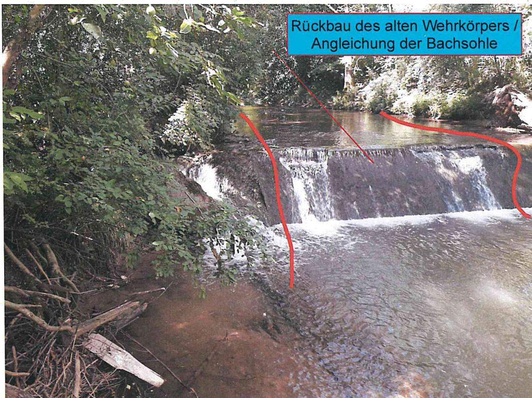
**Abb. 8:** Entwurfsskizze Variante II Rückbau des Wehrkörpers / keine Rampe
