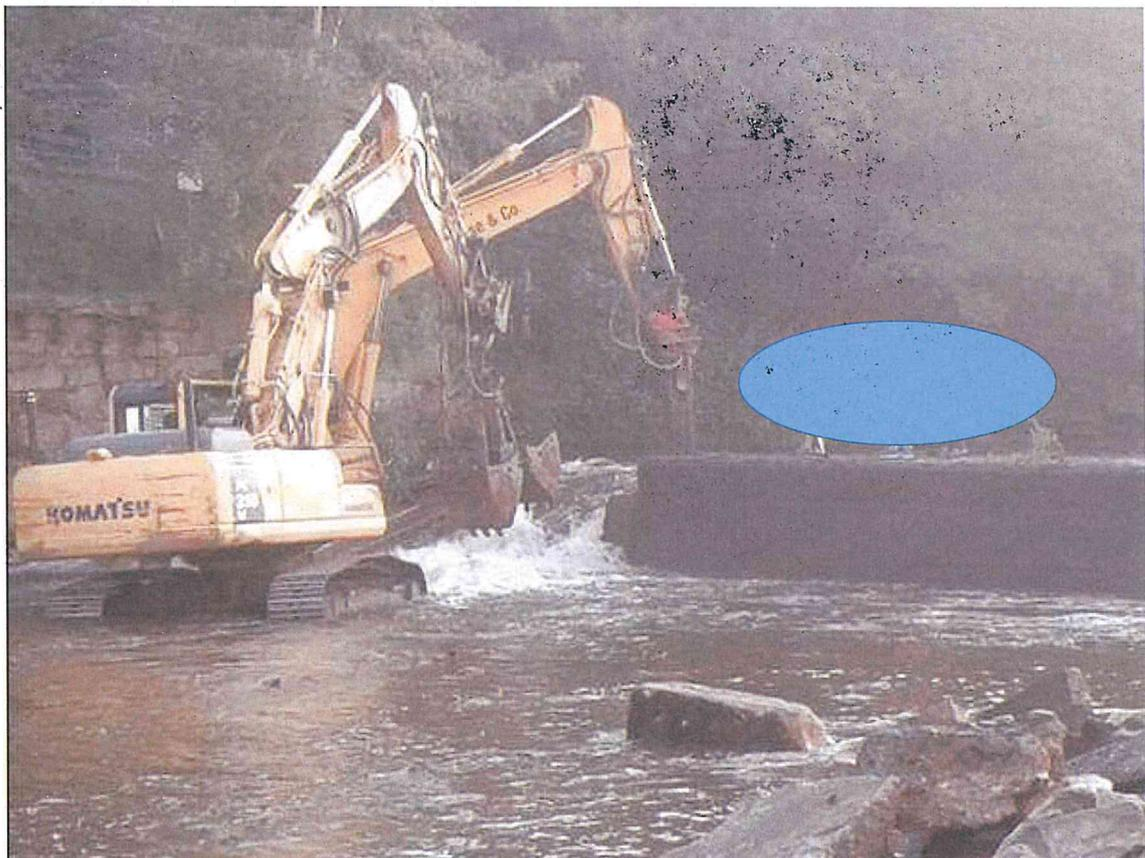
**Abb. 10:** Abriss / Teilabriss eines Wehres
