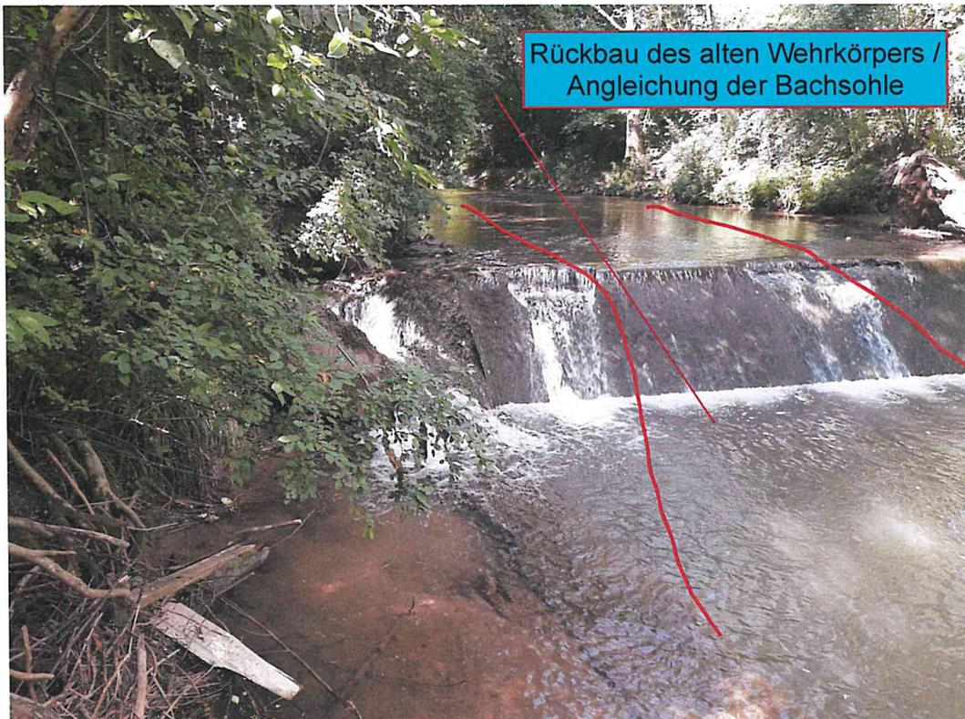
**Abb. 5:** Entwurfsskizze Variante I Schüttung einer Rauhen Rampe
