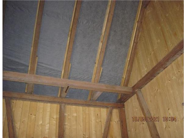
Abb. 8 : Dachgebälk der Scheune mit gedämmtem Dach
