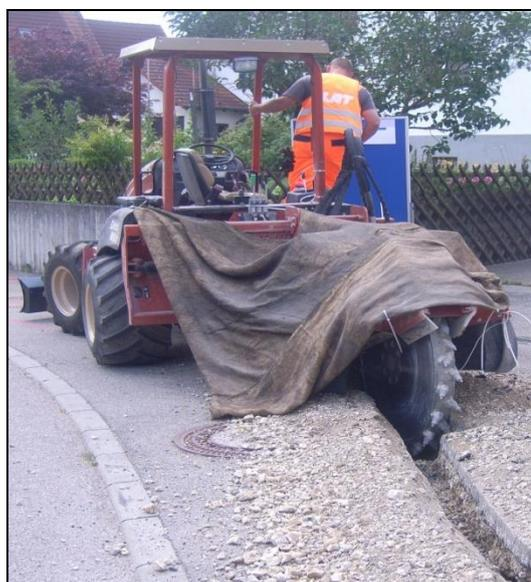
**Felsfräse (Trägergerät: Ditch-Witch)**
